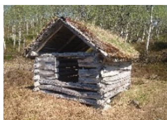
Utløe Ei typisk løa frå heia og heie-slåtten. Denne løa er lafta og vert kalla ei «veggjeløe».
