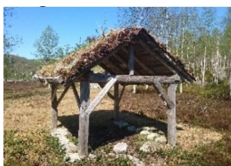
Løe (Stolpeløe) Dette var òg ei typisk løa fra heia. Dette er ei grindbygd løa, kalla for «stegeløa».
